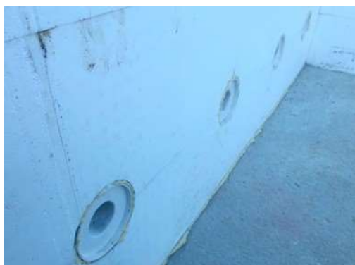
Kompletně zapěněná stěnová průchodka
