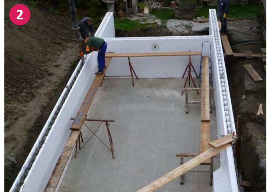
Zalítí polystyrenového bloku betonem
