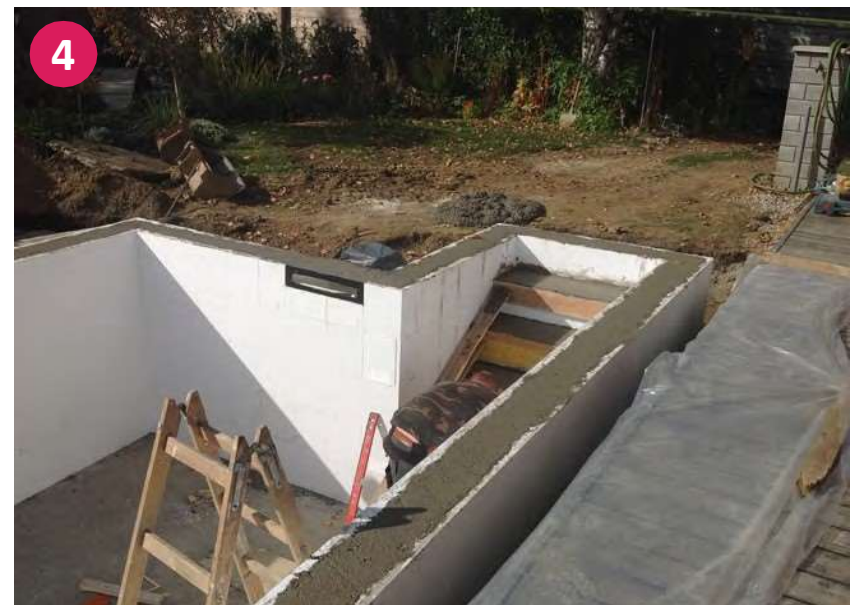
Zalítí polystyrenového bloku betonem
