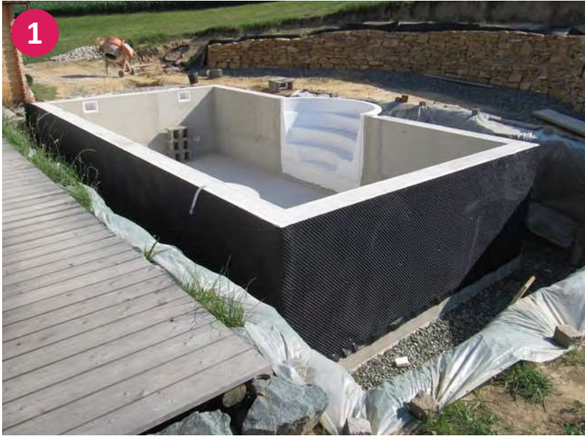
Vnitřní stěny doporučujeme navlhčit a vyrovnat
