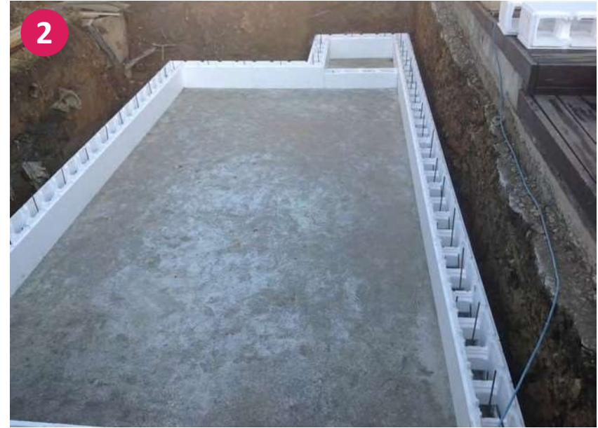
Usazení první řady polystyrenových bloků
