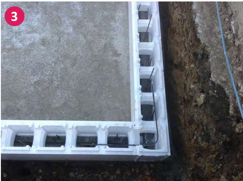
Detail rohového napojení včetně železné výztuže
