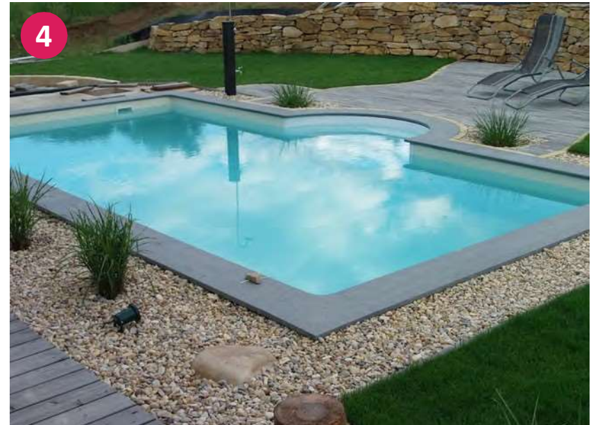
Hotový polystyrénový bazén s římskými schody
