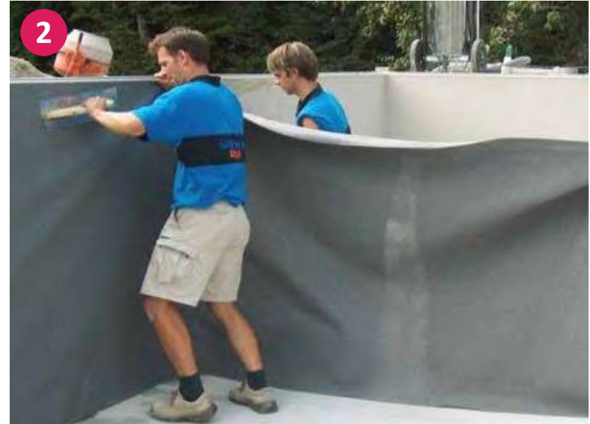
Bodové připevnění separační vrstvy z netkané geotextilie pomocí polystyrenového lepidla
