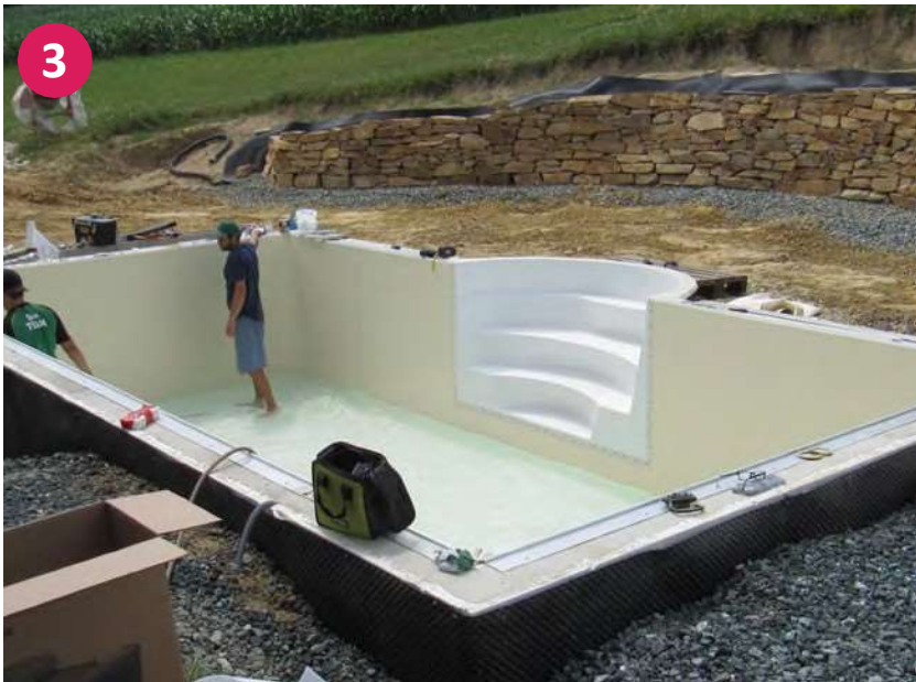
Zavěšení fólie a lemování na vestavěné díly
