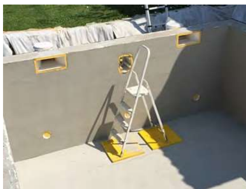
Hotová vnitřní stěna
