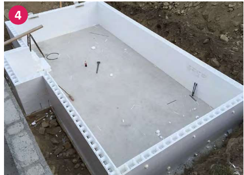
Hotový polystyrenový bazén - bez betonové výplně
