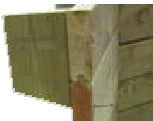
Zarovnejte dřevěný blok s horní částí desky.
