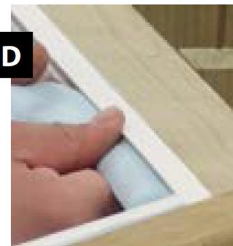
Chcete-li přesunout již umístěnou fólii, posuňte ji podél profilu. Pokud je to obtížné, může být fólie přesunuta zvednutím, aby nedošlo k jejímu poškození. Ujistěte se, že fólie je dobře umístěna jak na podlaze tak i na stěnách, tak rovnoměrně napnuta (snohou, urovnějte vložku do správného úhlu k rohům stěn).
