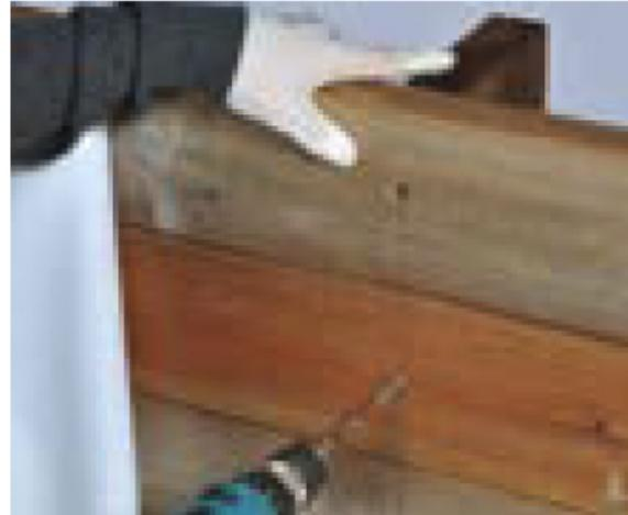
Fixujte dřevěné bloky pomocí šroubů 6 x 90 (1 šroub na desku). Pro snadnější přivrtání si otvory nejdříve předvrtejte.
