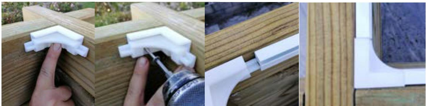
A Upevněte lištu pomocí 5 šroubů
