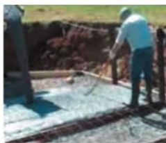
Konstrukce betonové desky
